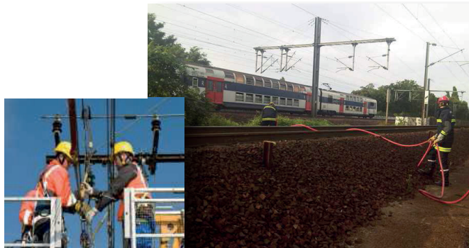
Interventions lors de fortes chaleurs.
