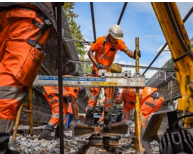
Travaux d'été 2018 dans Paris
