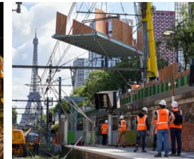
Mise en accessibilité de la gare de Javel
